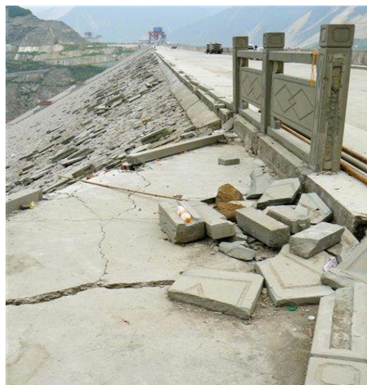
Рис. 1. Виды плотины «Зипингпу» после землетрясения [2, 3]
