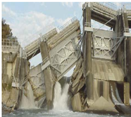
Рис. 3. Разрушение плотины Ши-Кань на Тайване во время землетрясения Чи-Чи 21.09.1999 г [2, 3]
